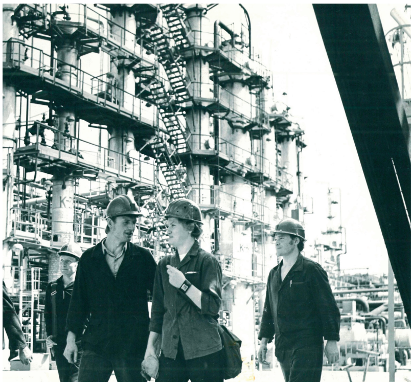
Общий вид головной технологической установки Мозырского нефтеперерабатывающего завода в 1975 г.
