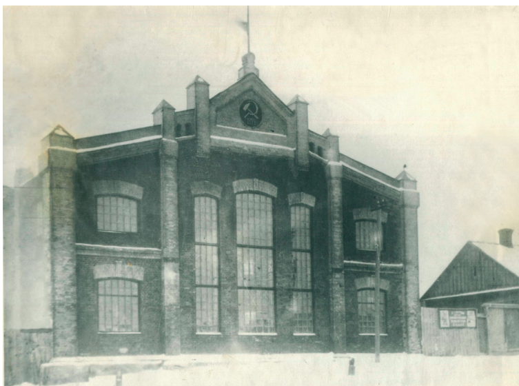
Восстановленный и реконструированный завод «Энергия» в Минске
